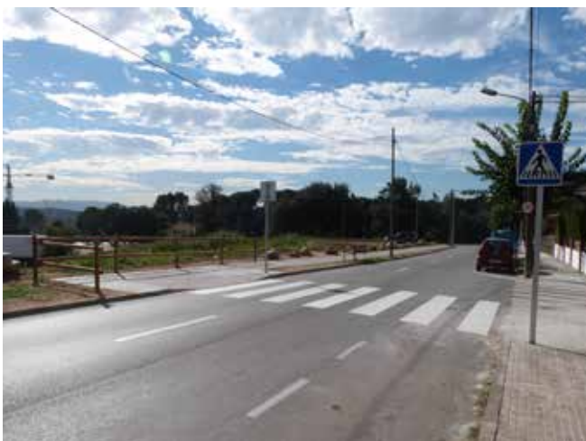
A més de la nova vorera, s'han pintat els passos de vianants i s'ha millorat l'accessibilitat de la zona
