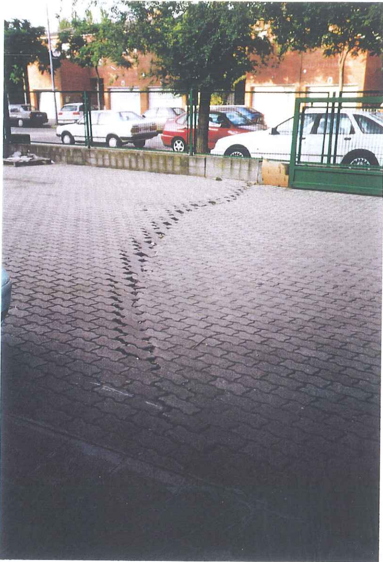
Foto 5: Vista del pati de la nau "El de Caldes", a on s'observa l'enfonsament del bloc SE de la falla.
