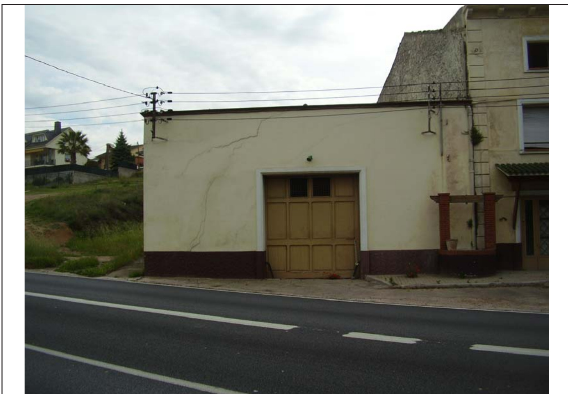
Fotografia 4. Vista de l'afectació de la falla al cobert de Can Periquet, Avda. Catalunya N° 70.
