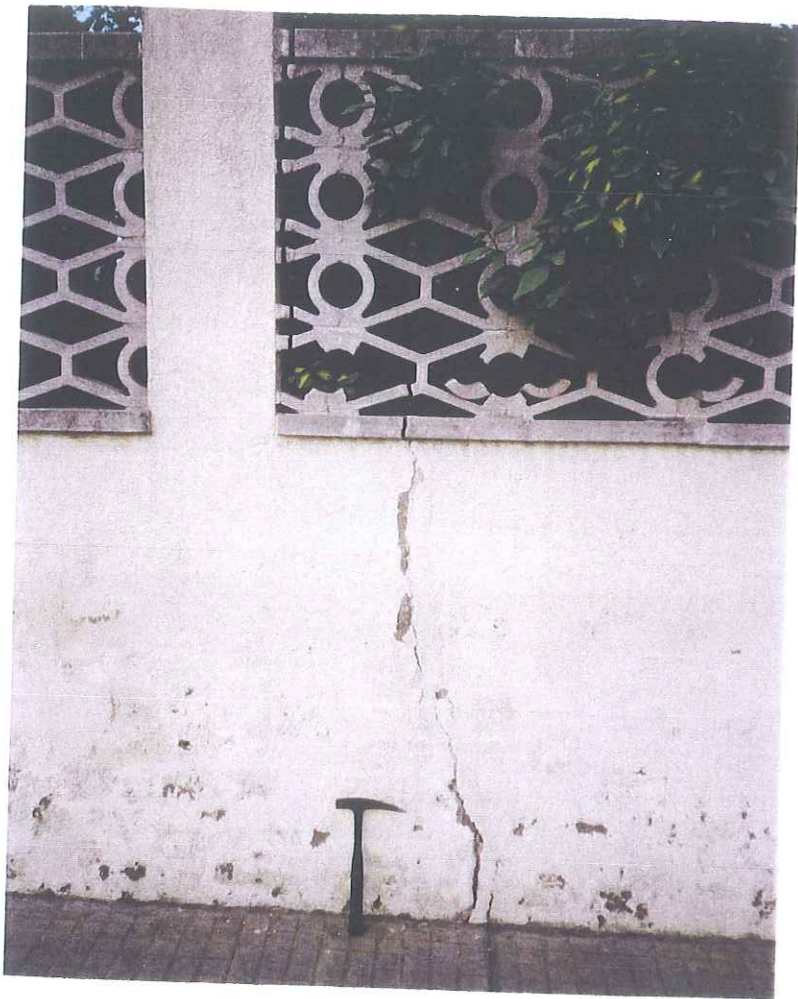
Foto 19: Separació visible en el mur del nº 19 del Carrer Farell.
