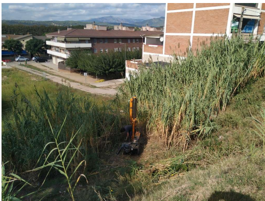
Realització de sondeig amb recuperació de testimoni continu (S2) .
