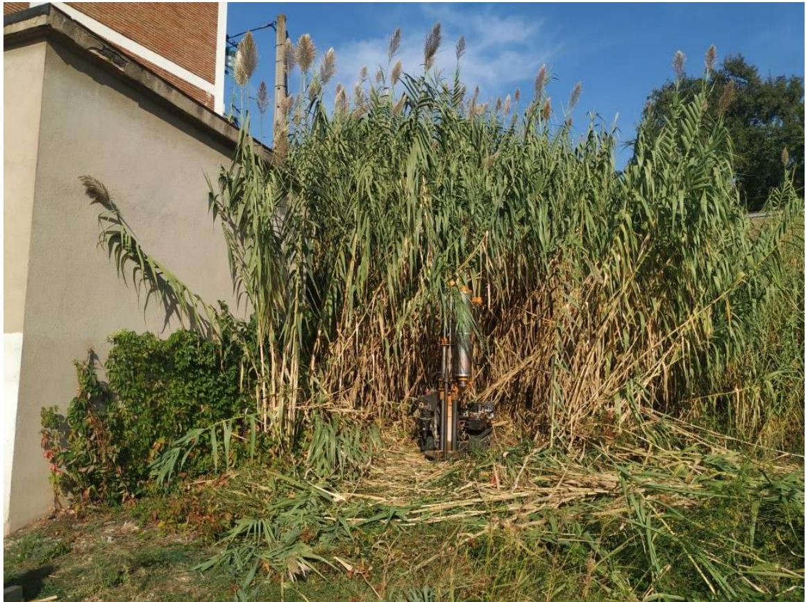
Realització de sondeig amb recuperació de testimoni continu (S3) .
