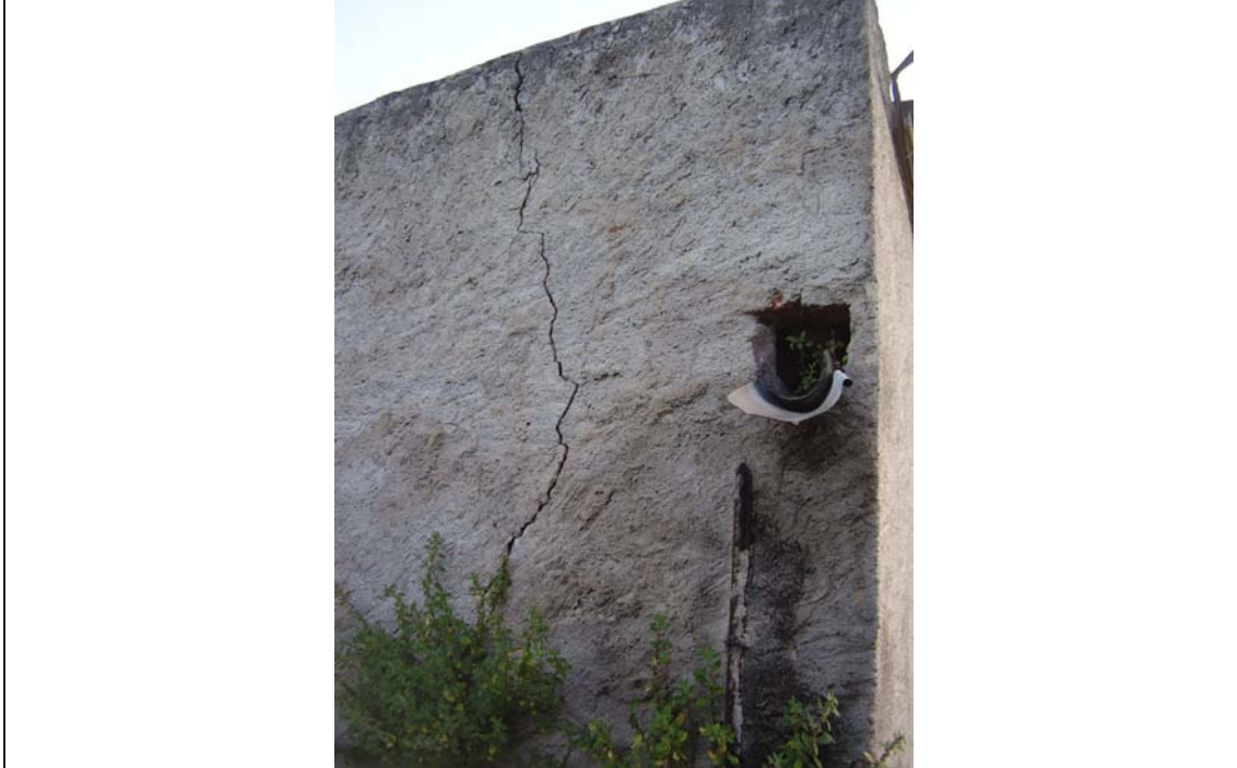
Fotografia 5. Vista de l'afectació de la falla a la façana posterior del cobert de Can Periquet.
