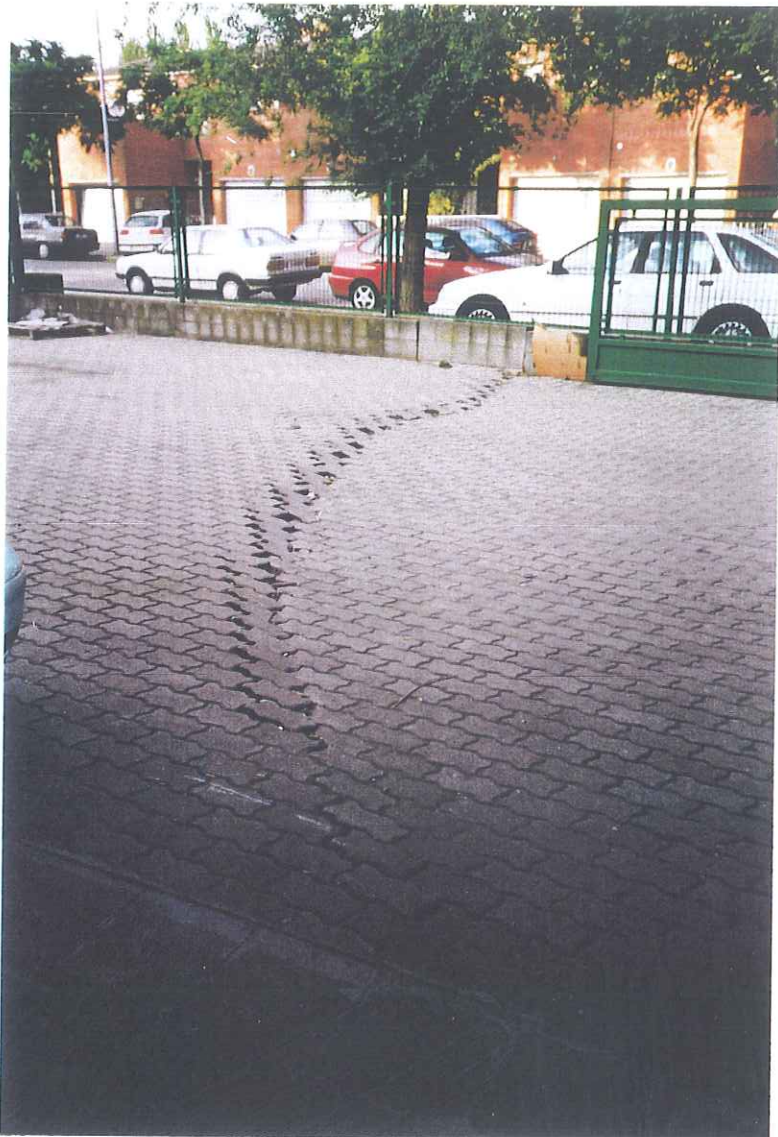
Foto 5: Vista del pati de la nau "El de Caldes", a on s'observa l'enfonsament del bloc SE de la falla.
