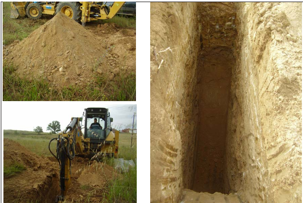
Fotografia 6. Detall de la calicata C5: màquina treballant, testimoni del forat i del material extret.
