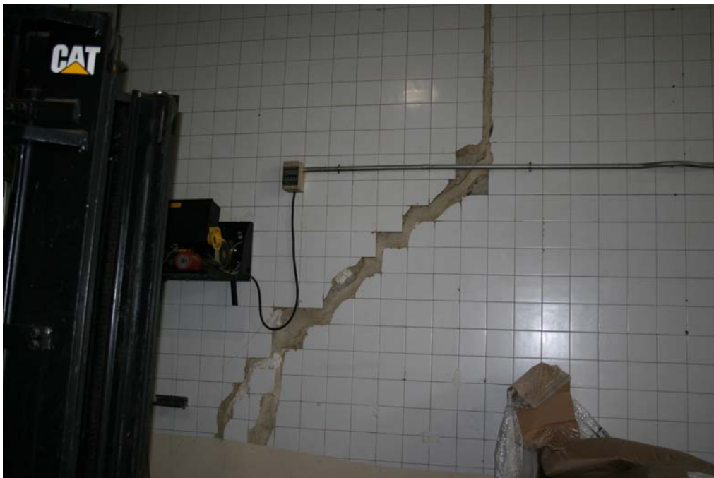
Fotografia 6: Esquerda a l'interior de la fàbrica Productes el de Caldes, al Polígon Industrial Riera de Caldes.
