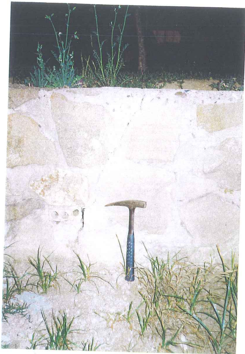
Foto 22: Vista de les fractures aparegudes en el mur del n° 5 del Carrer Cadí, ja reparades amb ciment.
