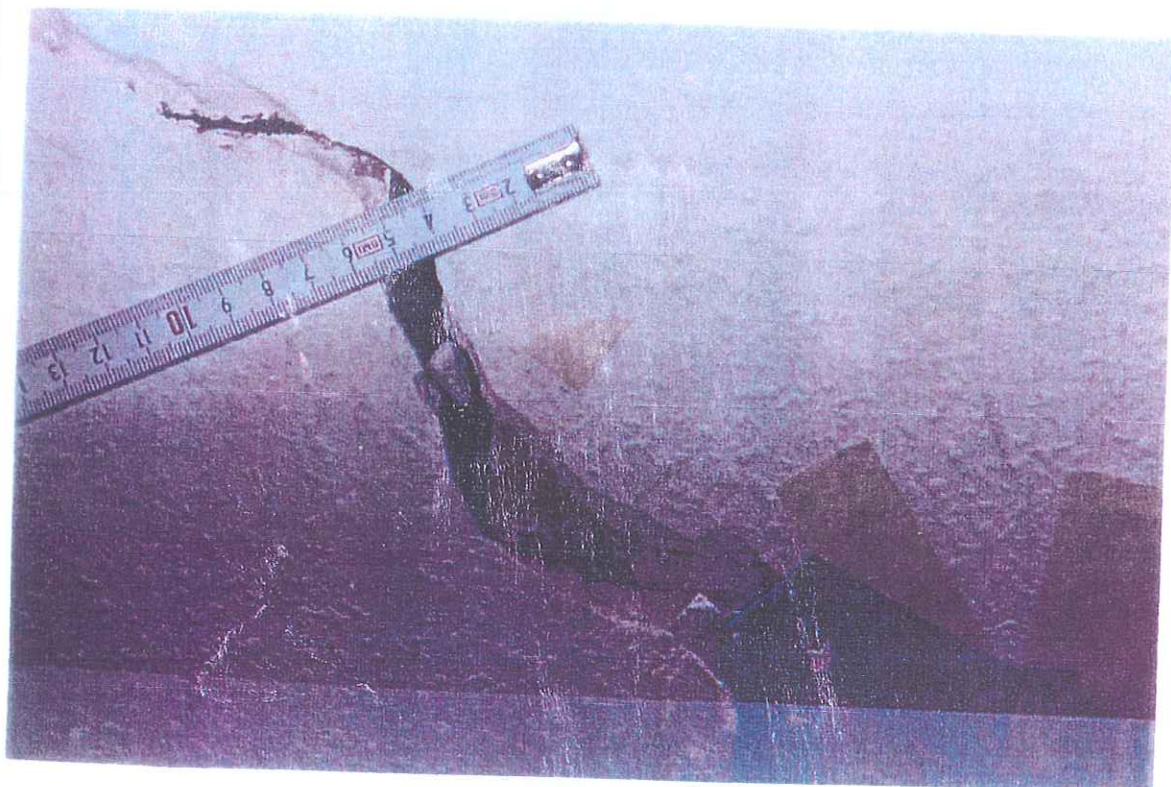
Foto 8: Detall de l'interior del n o 24 de la Ronda Boada Vell, on s'observa la magnitud de la separació en el mur (de Muñoz, 1991).
