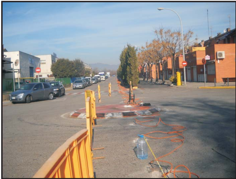
Perfil de tomografía eléctrica PTE-1A .
