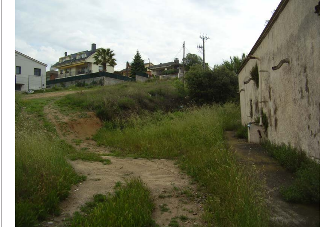
Fotografia 3. Panoràmica de la zona d'afectació de la falla vista des de l'Avda. Catalunya.
