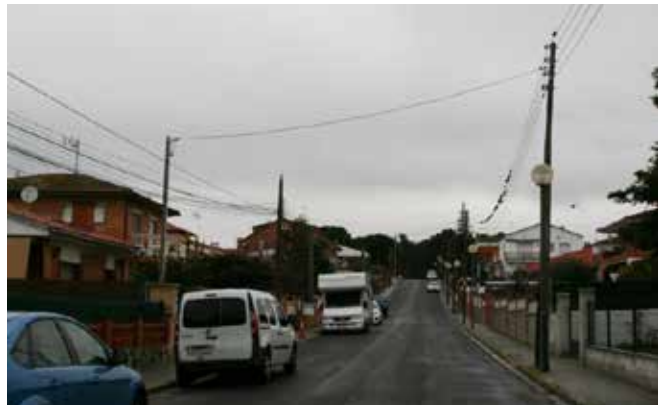
Nou asfalt al carrer Merla
